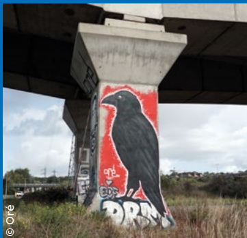
Oré - viaduc de Calix à Mondeville
