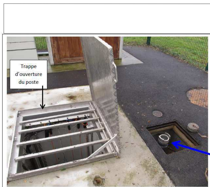
Regard contenant le tube vertical d'hydrocurage
