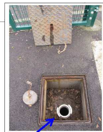
Regard contenant le tube vertical d'hydrocurage
